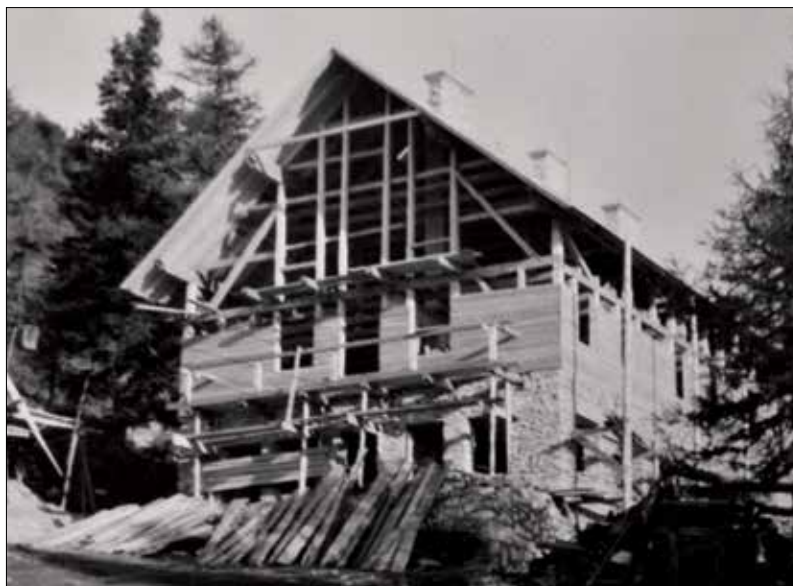
Dom na Peci v fazi gradnje leta 1957
